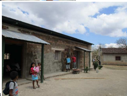
Reparando la capilla
